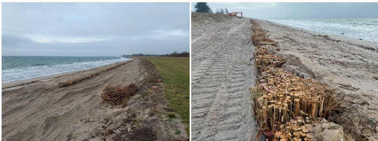
Figur 3-3 Fotos fra d. 30-01-2025 af etablering af kystbeskyttelses anlæg med pilebundter ved Langholm, Lolland.
