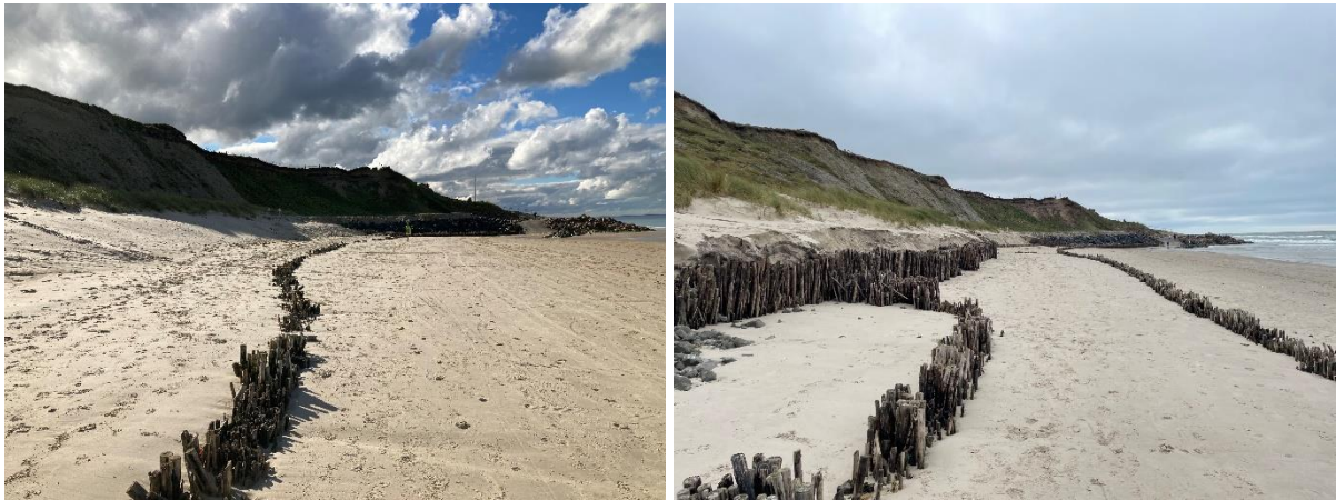
Figur 3-2 Fotos af anlæg ved Nr. Lyngby I fra forskellige tidspunkter 7 år efter etablering. T.v. foto fra d. 26.09.2025 efter en lang periode med roligt vejr. T.h. foto fra d. 17.10.2025 efter stormflod.
