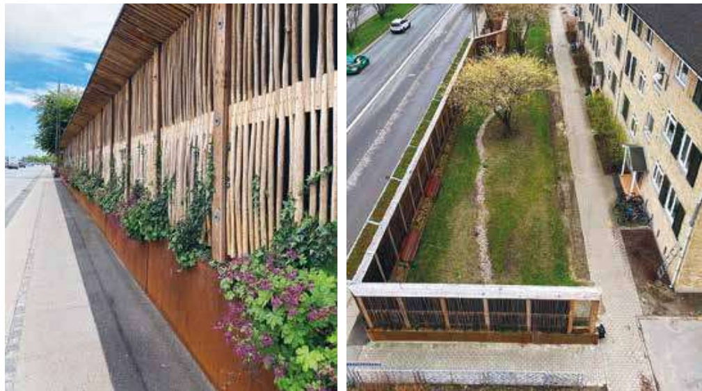
Figur 1: Gadevisning af den urbane Grøn Skærm til højre og en overhead-visning af den færdige struktur til venstre. Tagvand fra bygningen, der ses til højre, ledes via slanger indsat i de fire nedløbsrør under jorden og op til toppen af skærmen, hvor det fordeles og derefter absorberes i mineraluld, placeret i midten af skærmen. Eventuelt overskydende vand håndteres i det nye grønne rum, der ses mellem skærm og bygning.
