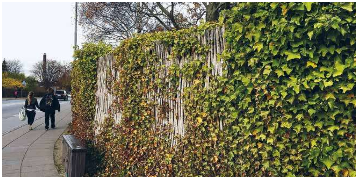
Figur 4: En pilebyg-støjskærm opstillet langs en trafikeret vej.
